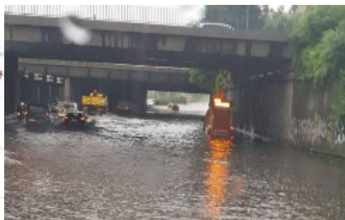
Inondation de l'autoroute A86 au niveau de La Courneuve (photo du Parisien)
