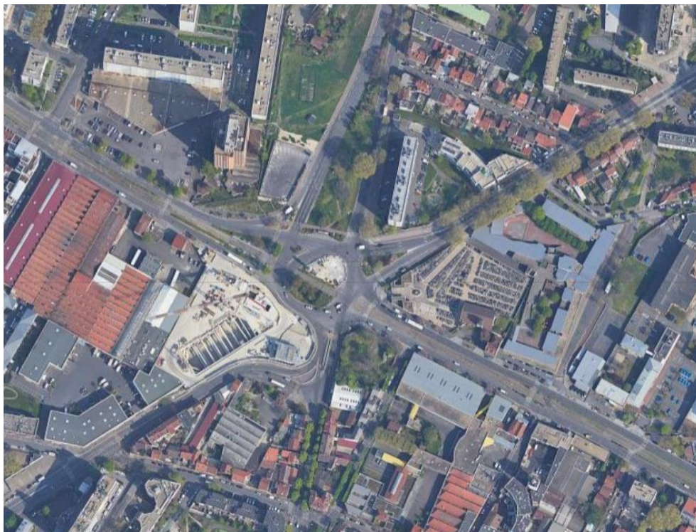
Vue aérienne du carrefour des Six routes – premières phases du chantier de construction de la gare du GPE
