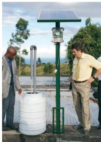
Technique d'adduction de l'eau grâce à une électrification photovoltaïque du réseau.
