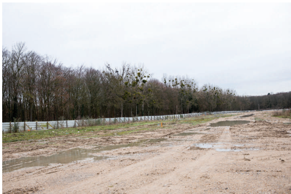
Après sa dépollution, le terrain doit être rattaché au parc Georges-Valbon.
