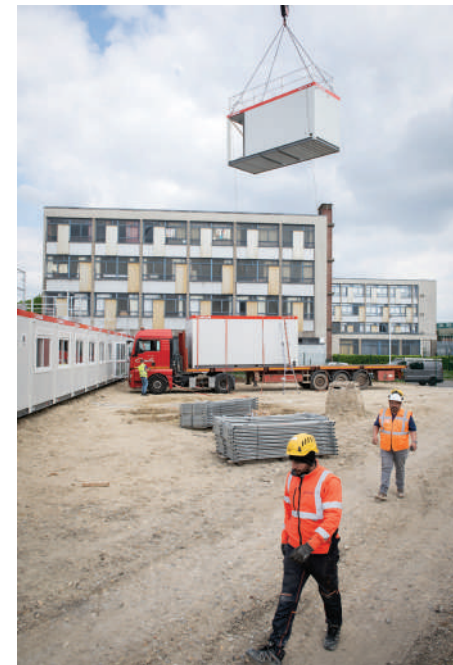
Installation des structures qui accueilleront l'école provisoire. Elles seront bientôt habillées d'un bardage en bois qui sera réutilisé dans la construction nouvelle.
