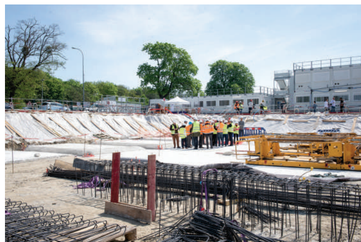
Cent vingt ouvrier-ère-s travaillent sur le chantier dont l'achèvement est prévu fin 2023.
