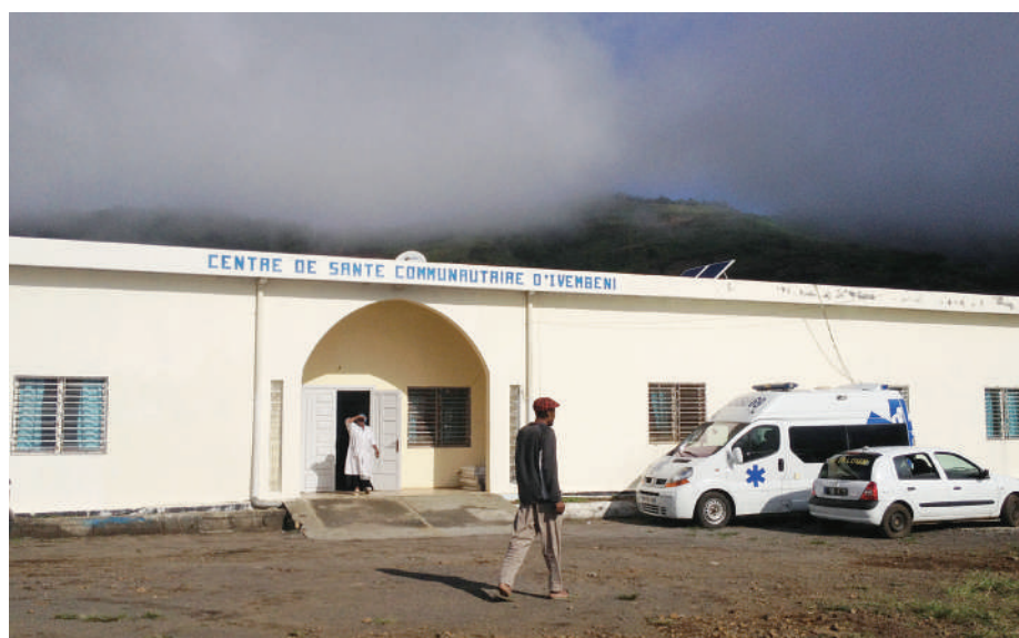
Le centre de santé d'Ivembeni, construit grâce à la coopération décentralisée.
