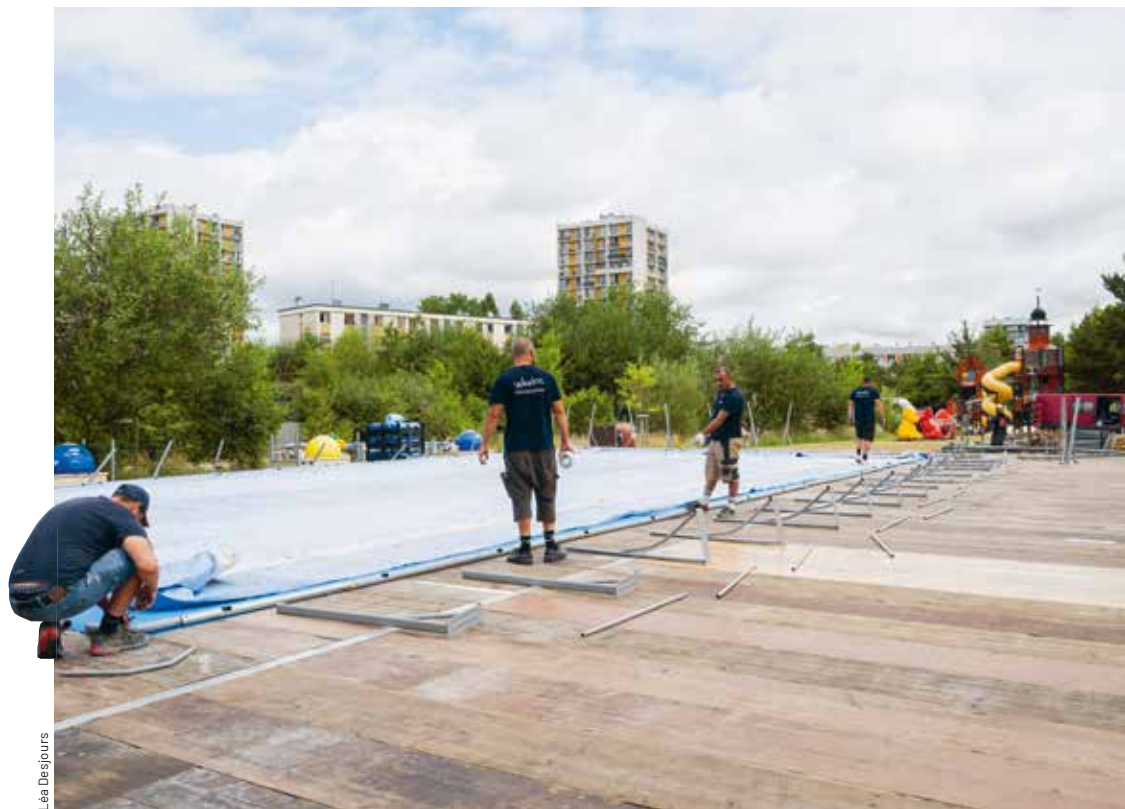
Quinze jours de travail pour l'installation des infrastructures au parc de la Liberté.
